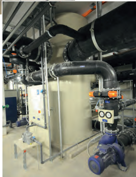
Im Technikraum unter dem Schwimmbecken sind die energieeffizienten SPECK Pumpen eingebaut.
